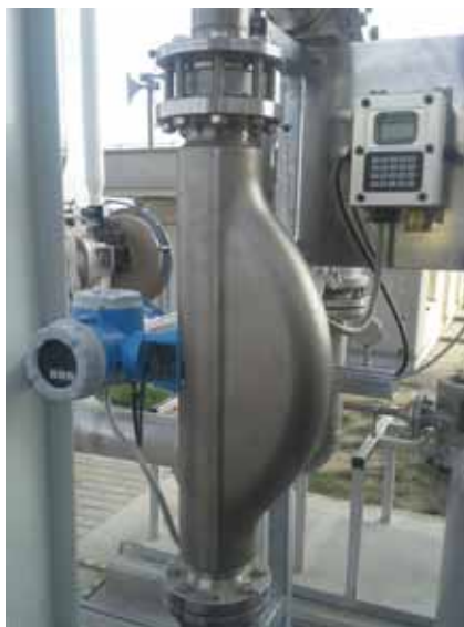
Rozliczeniowe układy do pomiaru przepływu benzyny i etanolu na Instalacji do Skażania Etanolu w Zakładach Produkcji Etanolu Bioagra SA w Goświnowicach koło Nysy
