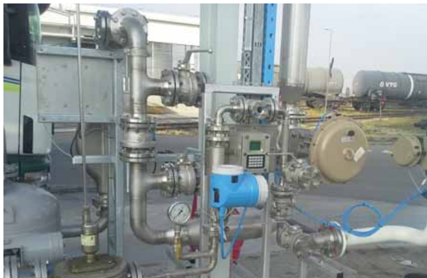
Rozliczeniowe układy do pomiaru przepływu benzyny i etanolu na Instalacji do Skażania Etanolu w Zakładach Produkcji Etanolu Bioagra SA w Goświnowicach koło Nysy
