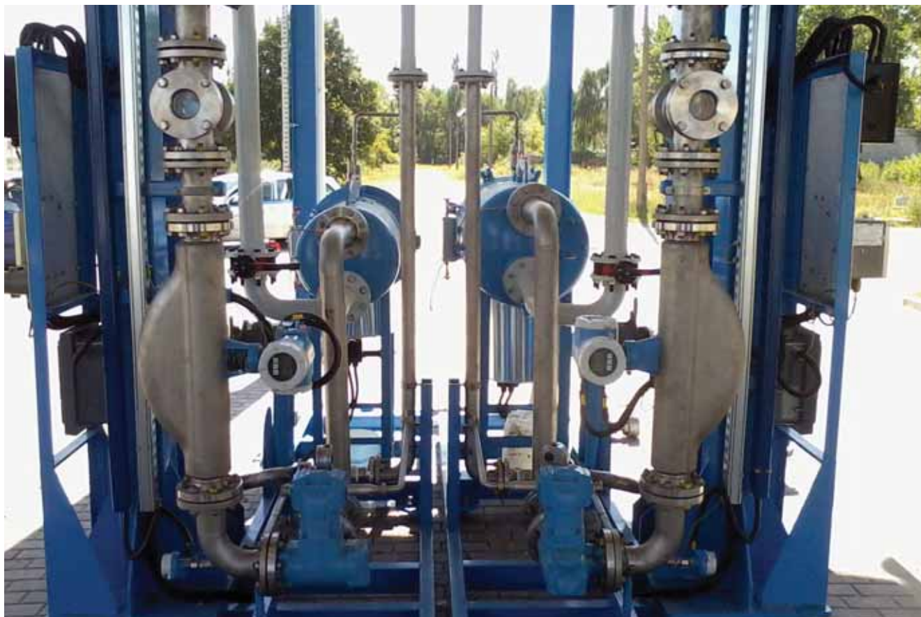
Front nalewczycy (skid) paliw lotniczych do autocysterny zrealizowany przez Endress+Hauser
