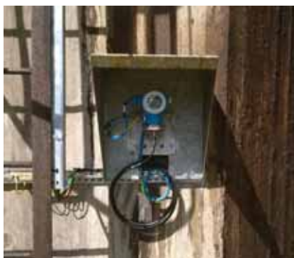
Deltabar FMD72 na Instalacji 1200 ekstrakcji i podwyższania jakości olejów mineralnych
