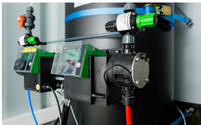
Generator dwutlenku chloru „Clorious2” – bezpieczne i pewne rozwiązanie do niezawodnej dezynfekcji wody pitnej, chłodzącej i procesowej
