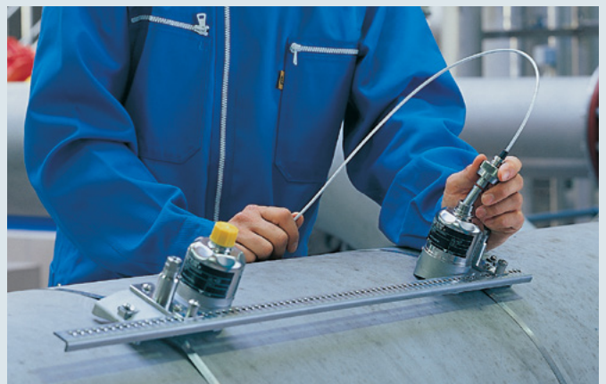
Weryfikacja zainstalowanych przepływomierzy
