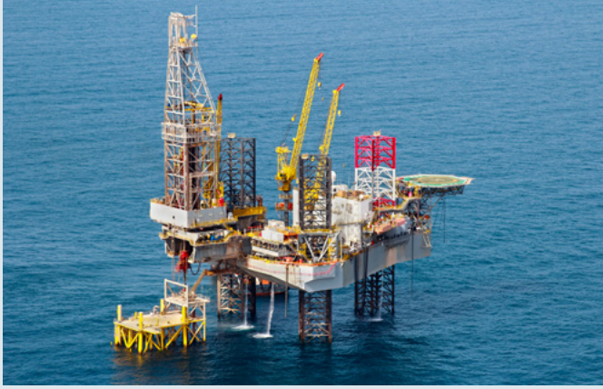
Węglowodory ciekłe, np. ropa surowa (na lądzie i morzu)
